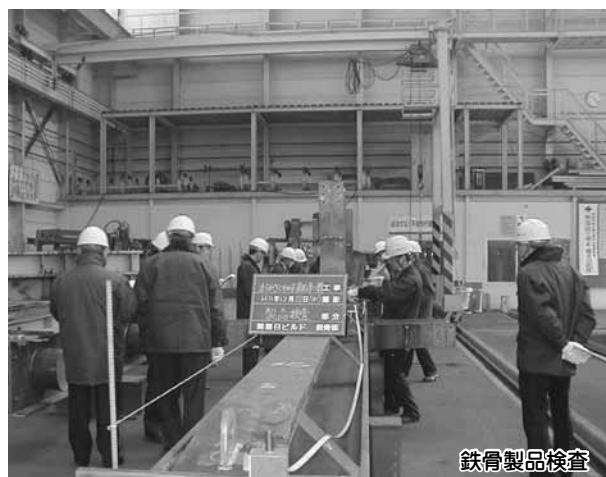
屋根大梁配筋検査
